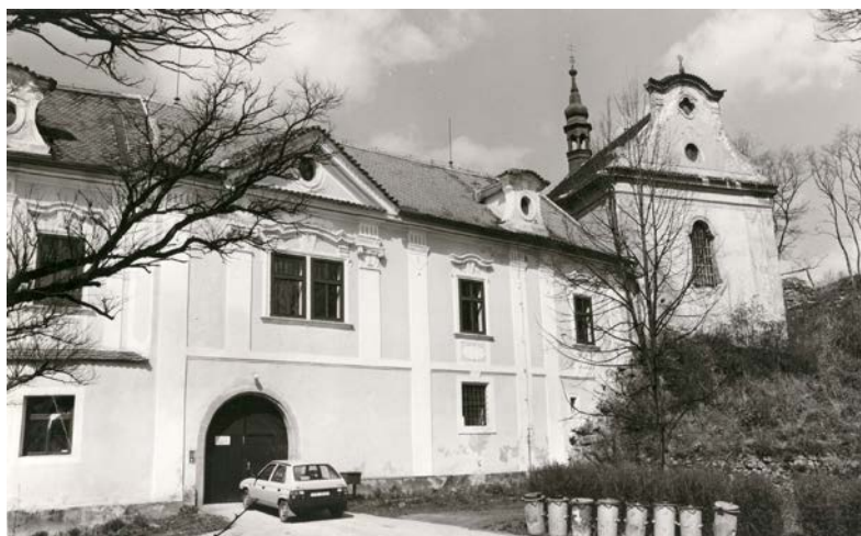
Obr. 5. STŘELA – vstupní čelo dolního hradu s bývalou hradní kaplí.
