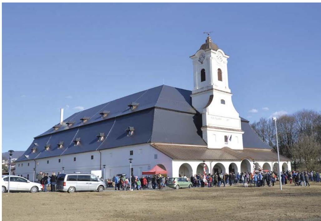
Zrekonštruovaný sklad soli. Foto Branislav Švorc
