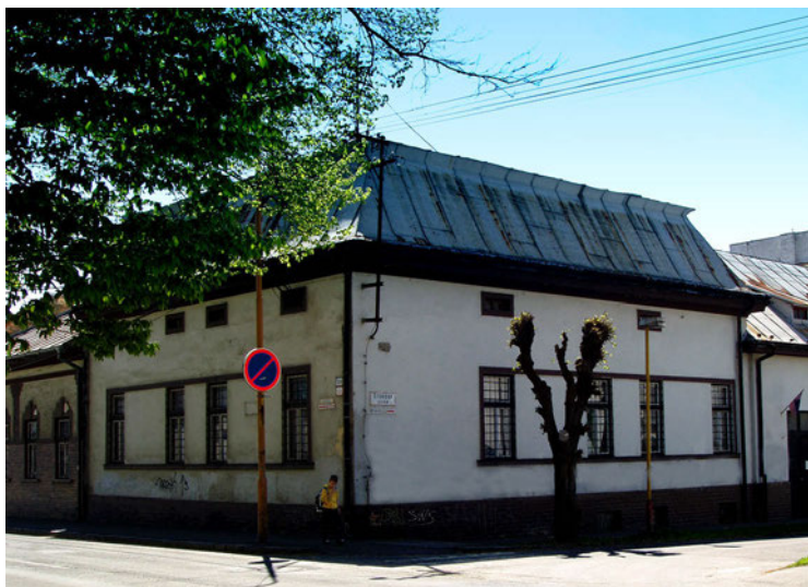
Budova Štátneho archívu v Prešove, pobočka Humenné
